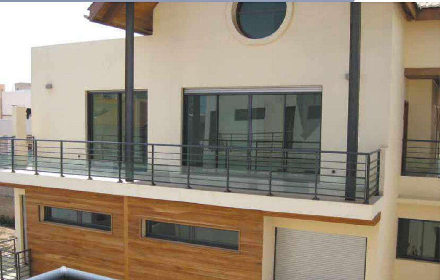
Solution TECHNAL utilisée : Garde-corps GYPSE simple poteau
